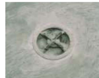
コンクリート打設 養生
