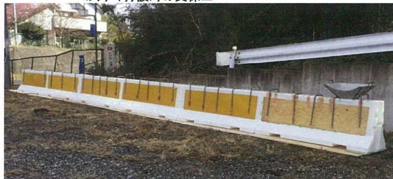
コンクリート打設時の支保工
